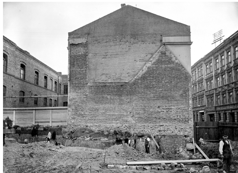
Das Gelände des Stadtbades nach dem Abriss der historischen Bebauung 1913 mit der Brandmauer der noch heute existierenden klassizistischen Villa in der Schimmelstraße 5 / StAHalle
