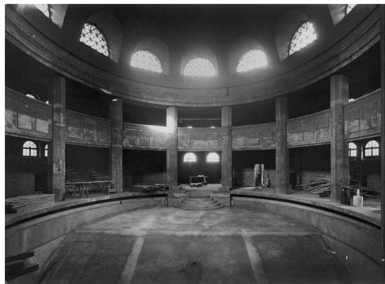
Männerhalle und Frauenhalle im Bau / StAHalle
